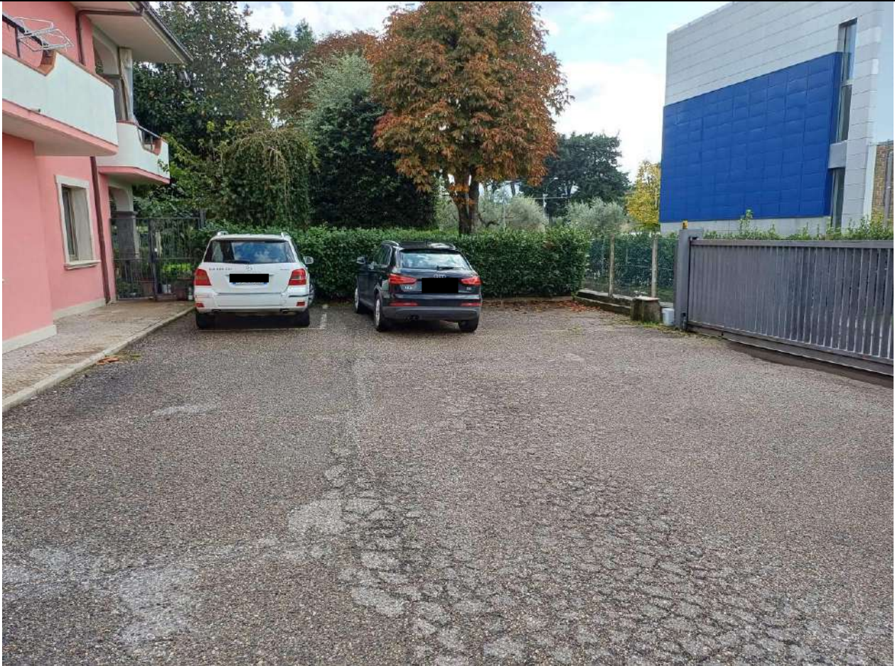
Foto 2 – Vista esterna accesso da area di pertinenza Foglio 134 P.Illa 100 sub. 3 Piano Terra
