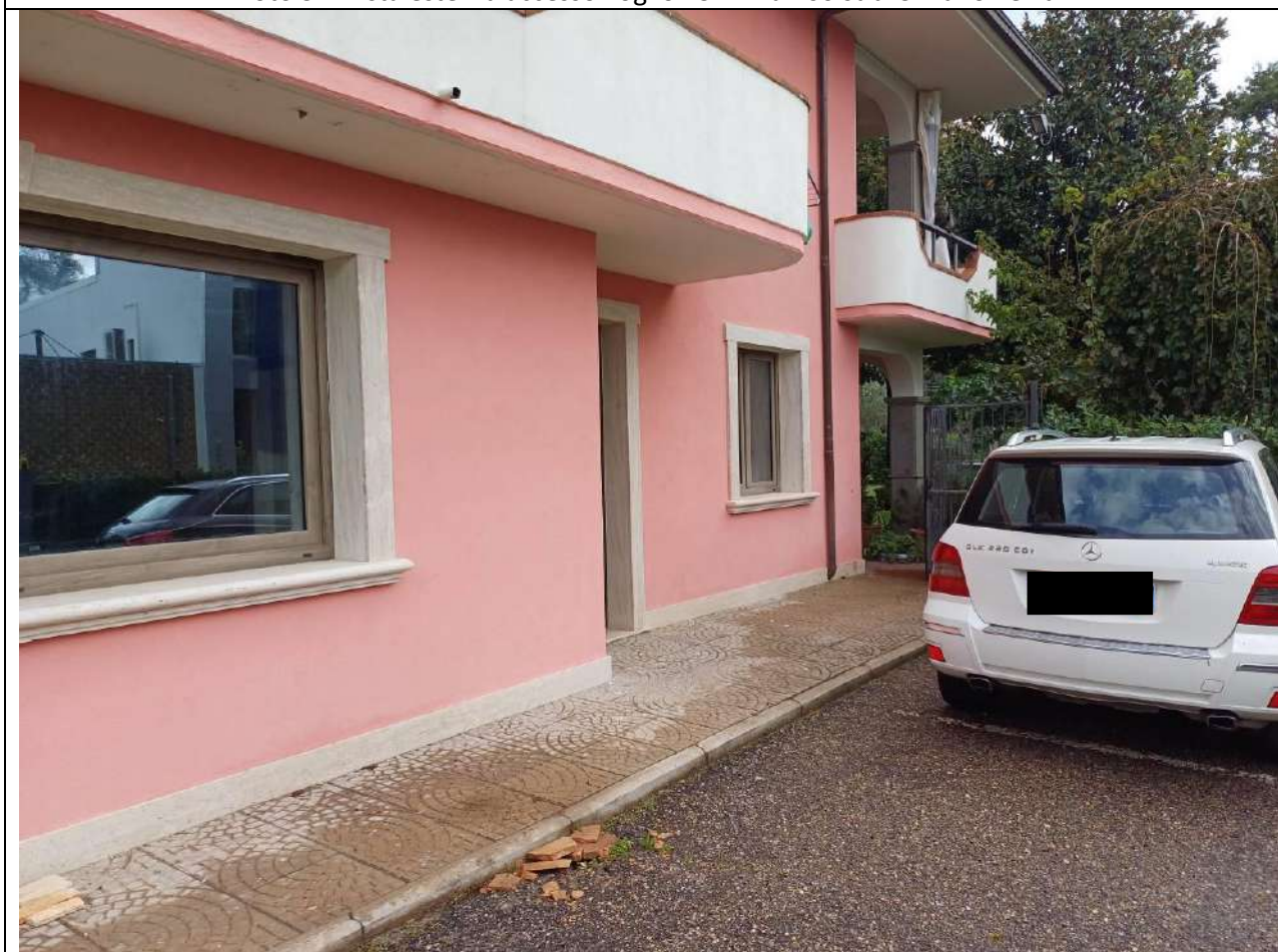
Foto 4 – Vista esterna Foglio 134 P.Ila 100 sub. 3 Piano Terra
