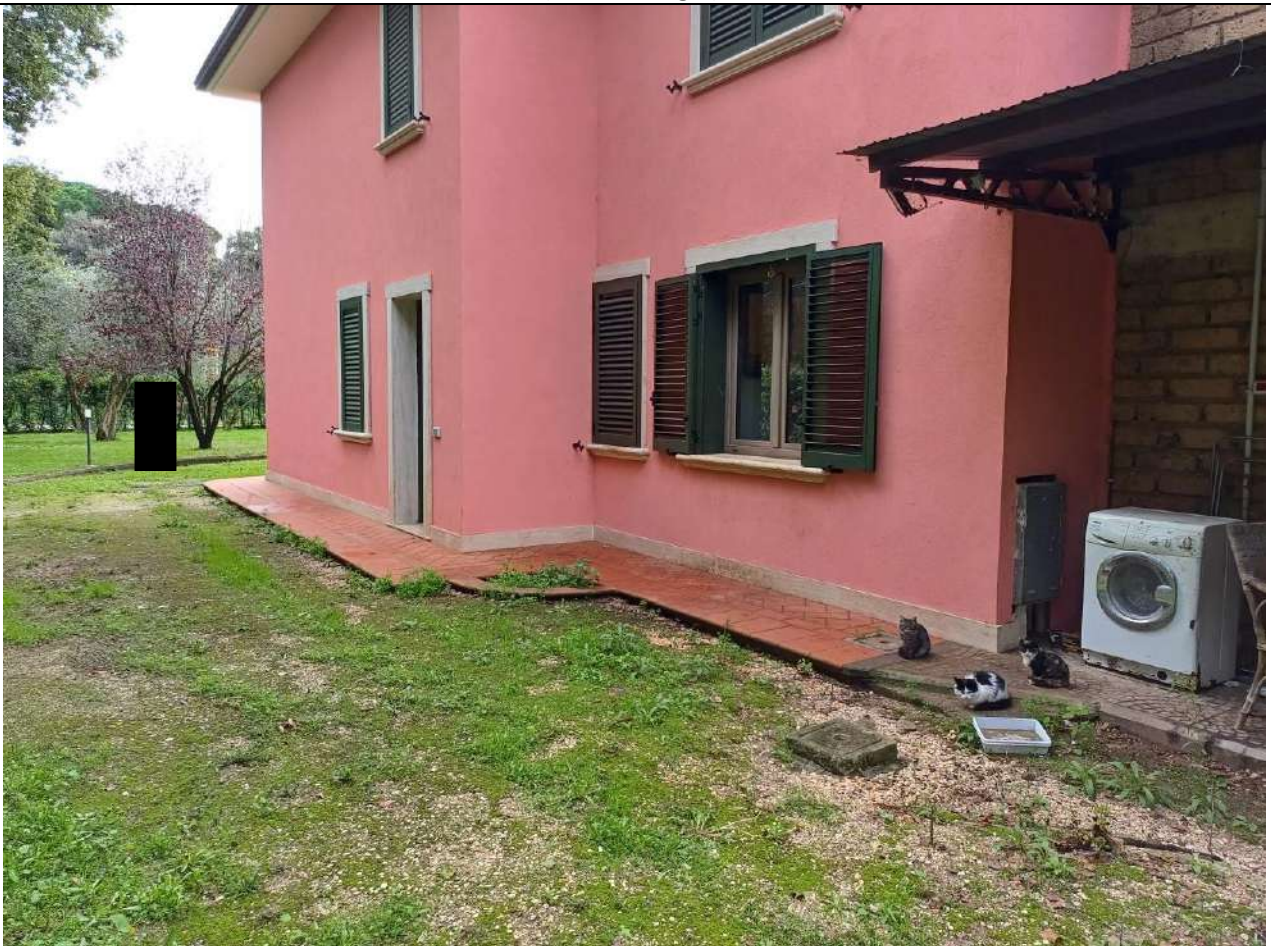
Foto 16 – Vista esterna Foglio 134 P.IIa 100 sub. 4-5 Piano Terra
